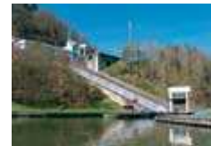
Ein Schiffshebewerk wie hier in Arzviller am Rhein-Marne-Kanal soll die Höhenunterschiede zwischen dem geplanten Tunnel und der Etsch ausgleichen.
